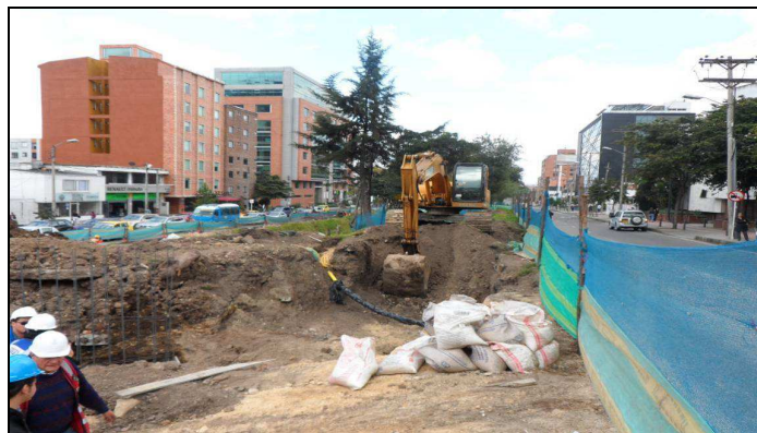
Imagen 1. Trabajos de excavación para el nuevo carril de incorporación y construcción muro de contención talud inferior. Frente calle 127
