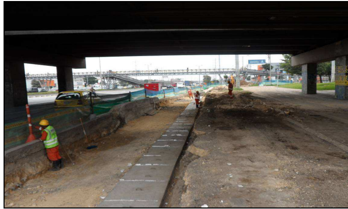
Imagen 2. Protección de tubería con placas de concreto y conformación de la nueva estructura de pavimento. Frente calle 134.
